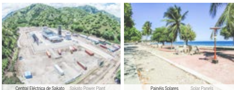
Central Eléctrica de Sakato Sakato Power Plant
