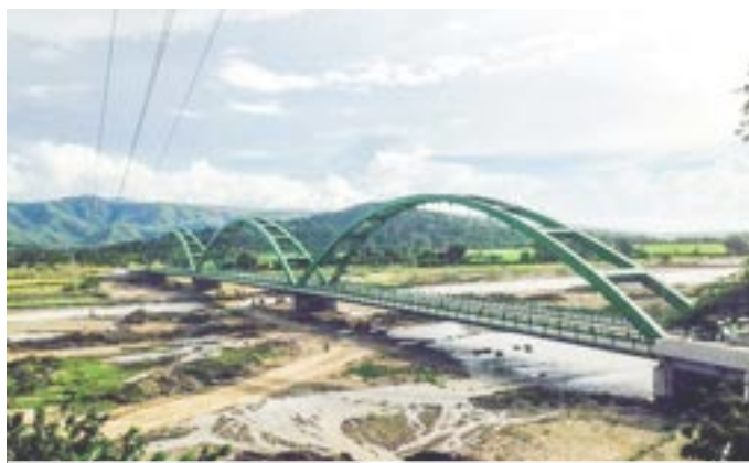
Ponte do Tono Tono Bridge
