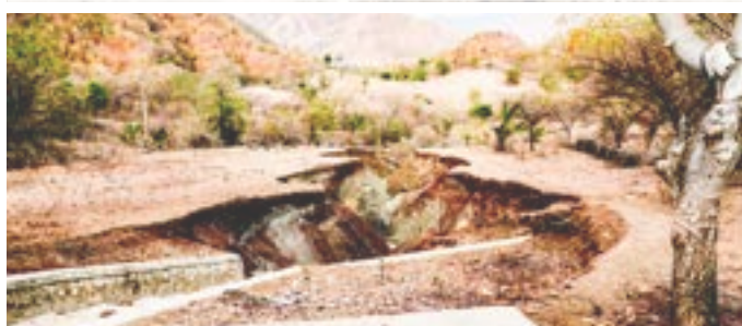
Erosão ao Longo da Estrada Erosion Along the Road
