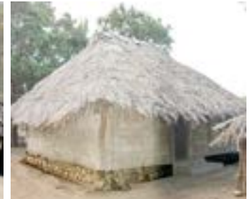
Alvenaria de Pedra Stone Blocks
