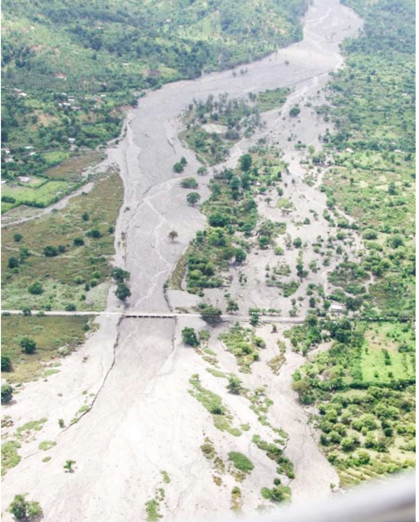
Infraestrutura Vulnerável, Timor-Leste
