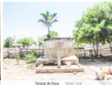
Tanque de Água Water Tank
