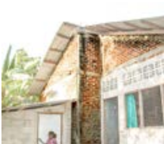
Alvenaria de Tijolo Brick Masonary
